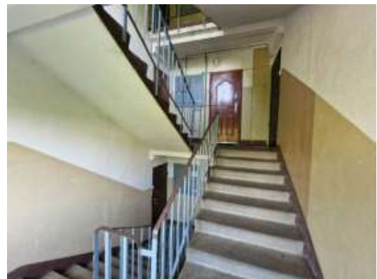
4.stāva kāpņu telpa
